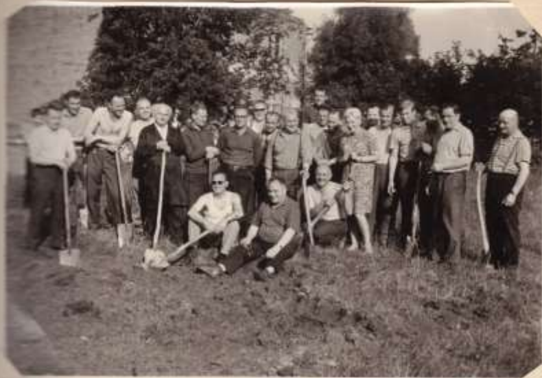
rozpoczęcie budowy - usuwanie ziemi m-c lipiec 1969 rok
